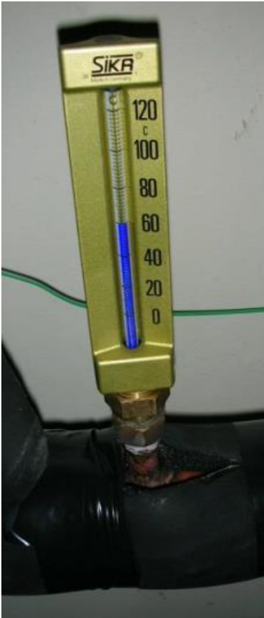
Thermomètre au doigt de gant ( à privilégier )
